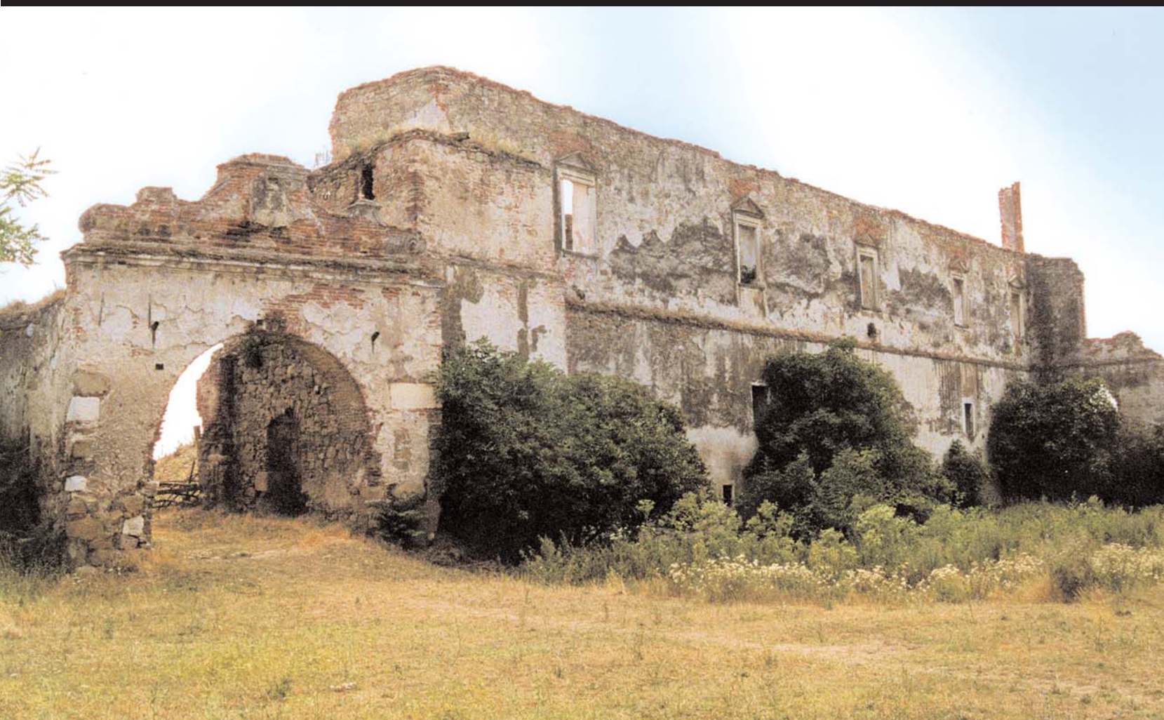
A kastély kapuja a tető nélküli palotával.
